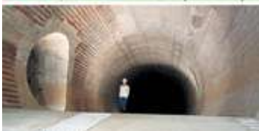
上画像:東京都の「神田川・環状七号線地下調節池」位置図より。下:東京都の「神田川・環状七号線地下調節池」パンフレットより (画像クリックで拡大表示)
