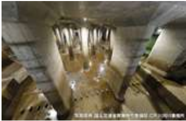
「首都圏外郭放水路」(防災地下神殿)の威容 (画像クリックで拡大表示)
