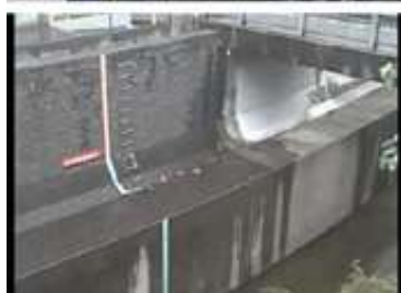
上画像:「デジタルツイン実現プロジェクト」HPのイメージ。下:東京都水防チャンネル(建設局)より「渋谷川」ライブ動画例より(渋谷橋映像監視局/渋谷区恵比寿1) (画像クリックで拡大表示)
